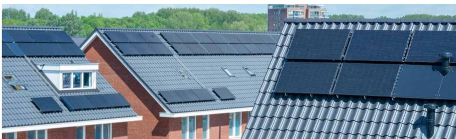
Abbildung 6: PVT-Module auf dem Dach von einem Reihenhäuser. Quelle: Triple Solar
