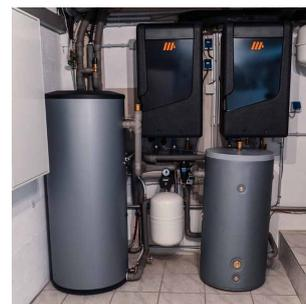
Abb. 5: PVT-Wärmepumpe im Heizungskeller. Quelle: Triple Solar
