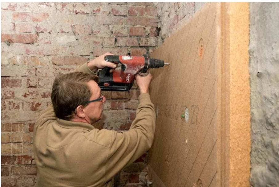
**Abbildung 2:** Anbringen einer Innendämmung aus Holzweichfaserplatten | Foto: Udi Dämmsysteme GmbH
