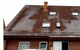
Mängel an der Dachdämmung kann man nach leichtem Schneefall an unregelmäßiger Abtauung erkennen.
