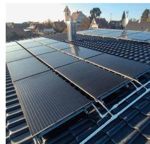
**Abb. 3:** PVT-Module auf dem Dach. Quelle: Triple Solar
