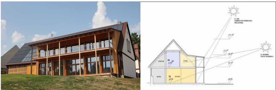
Abbildung 3: Nutzung der passiven Solarenergie, Foto: Hofgut Erler GbR
